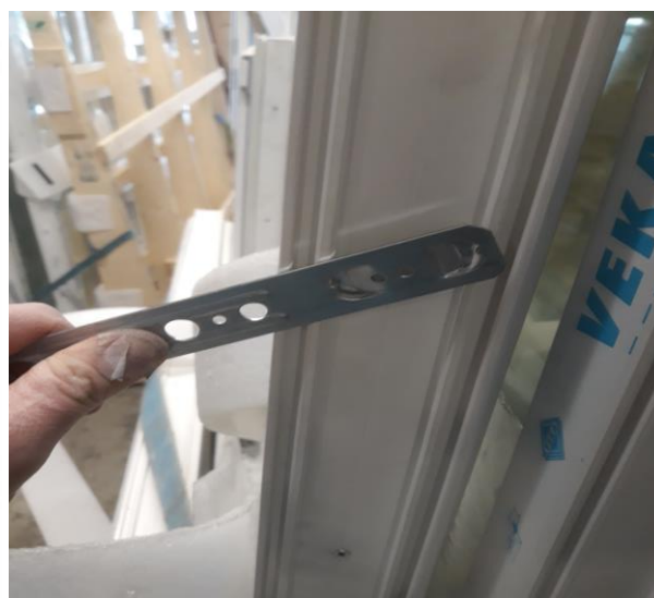
Bilde 2 viser beslaget i sporet, vri beslaget til det står fast i vannrett posisjon.
